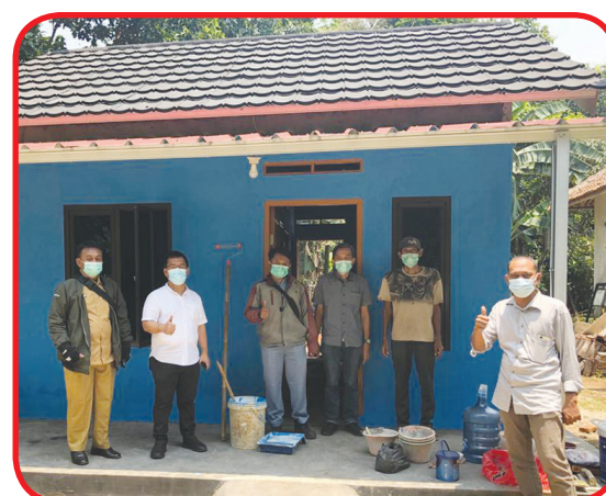
Rumah warga Desa Jatake sesudah direnovasi.
