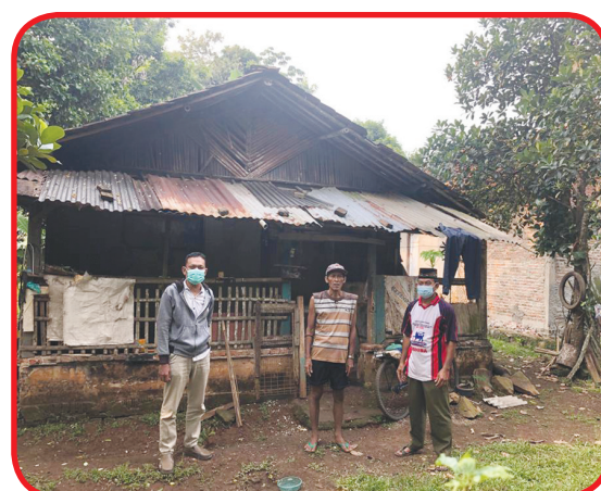
Rumah warga Desa Jatake sebelum direnovasi.
